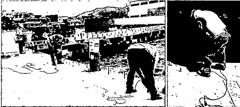
IMAGEN 10 Demolición del Piso, H=0.10m, con uso de chaleco salvavidas
