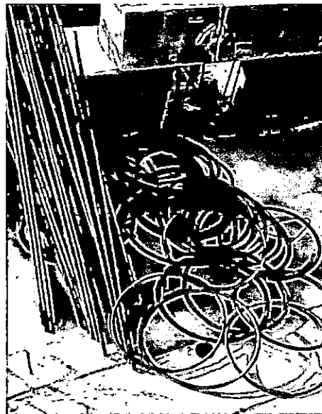
IMAGEN 14 Habilitación de estribos circulares para pedestales
