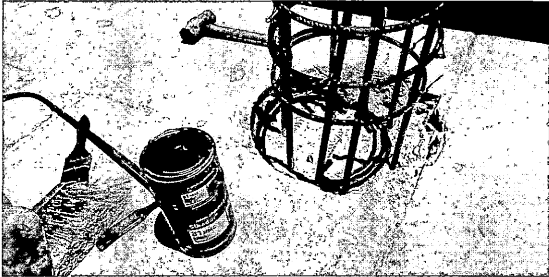
FOTO N°009 – Anclaje de aceros
