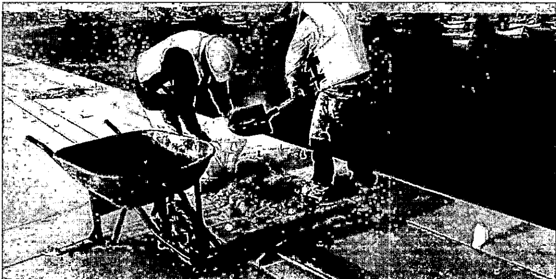
FOTO N°010 – ACARREO POR DEMOLICION DE LOSA
