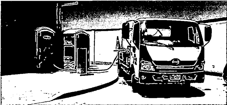
IMAGEN 03 Obras Provisionales - Servicios Higiénicos Portátiles Disal
