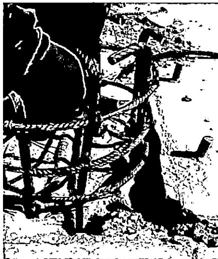
IMAGEN 15 Simulación de anclaje del acero de refuerzo
