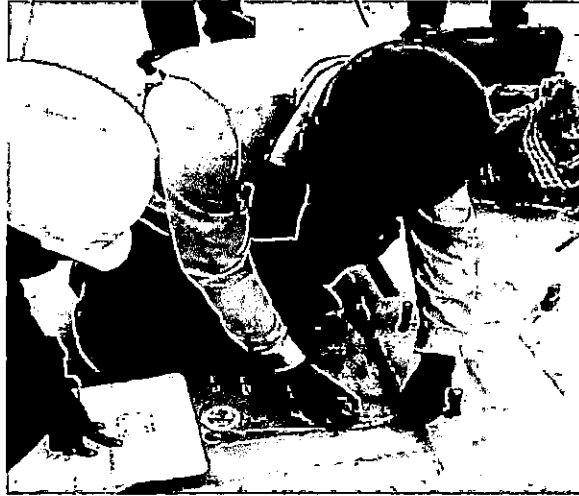
IMAGEN 07 Replanteo de ubicación del eje de pedestales
